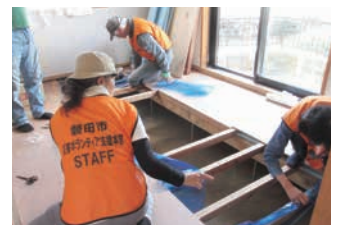
床下養生作業
