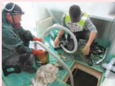
泥などが飛び散るのを防ぐため養生をして作業
